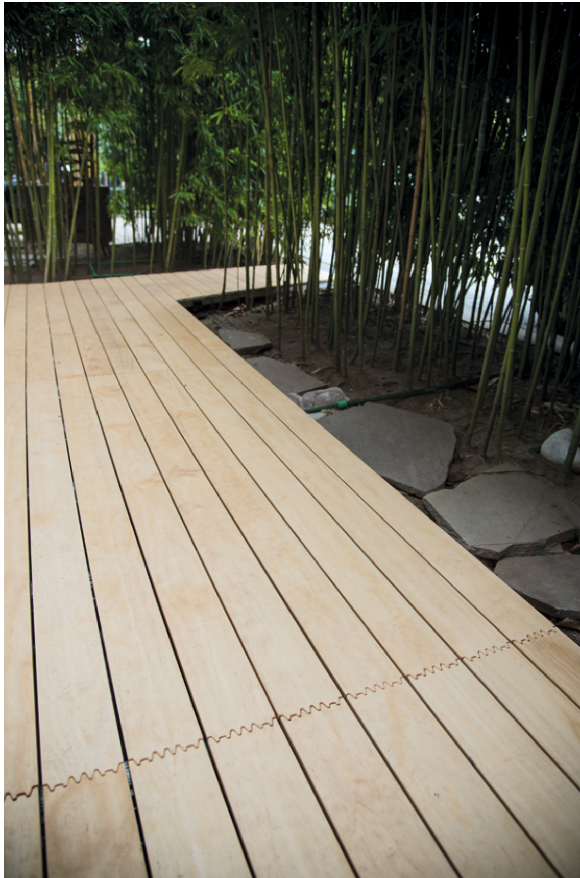
Decking Cross Finger, Atelier Sadler / DESIGN: Marc Sadler / LUOGO: Milano
